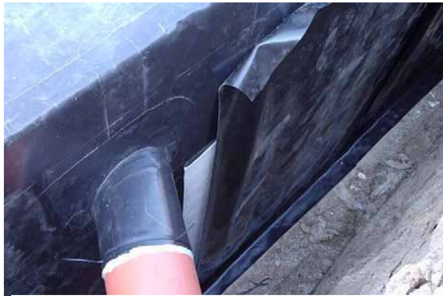
6. Detail opracovania prestupovej rúry, za ňou vidno časť zvislej (bielej) drenážnej vrstvy a druhú zvislú hydroizolačnú fóliu.
